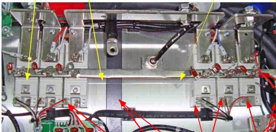
Клеммы управления 4 и 5 диодно-тиристорных модулей фазы R (подключение щупов осциллографа)
