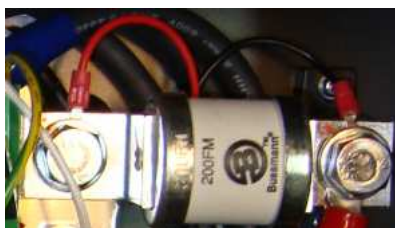
Рис. 6.7. Демонтаж силового предохранителя.
