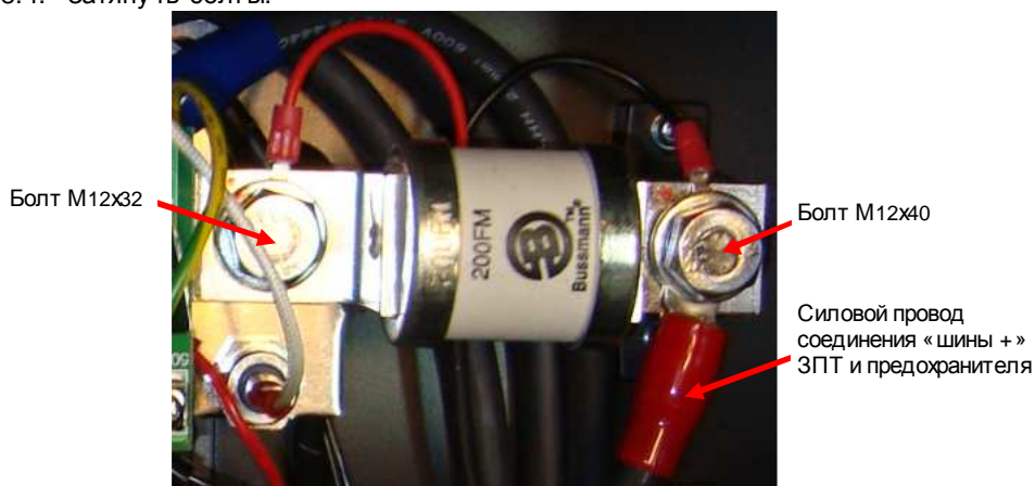
Рис. 7.20. Установка силового предохранителя.
