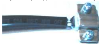
Рис. 6.20. Демонтаж датчика температуры.
