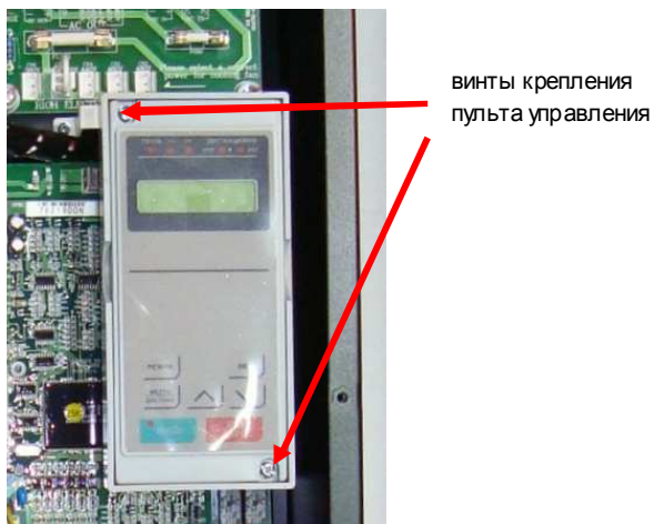
Рис. 6.2. Демонтаж пульта управления.
