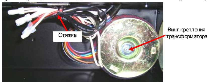
Рис. 6.26. Демонтаж трансформатора питания вентиляторов.
